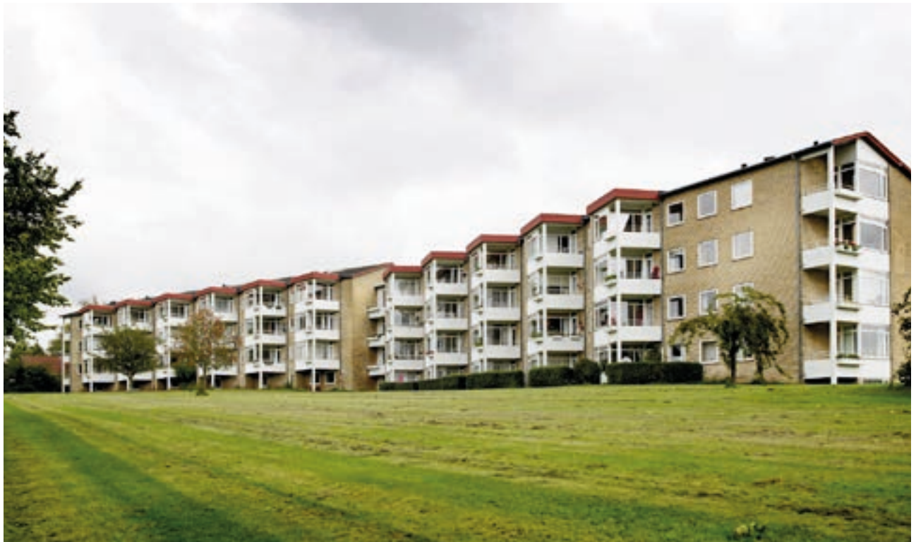
Renovering i gang i Søvangen Afd. 2
