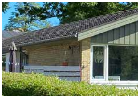
Ny efterisoleret skalmur af tegl.
