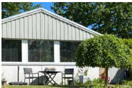
Udskiftning til vinduer med energiruder.
