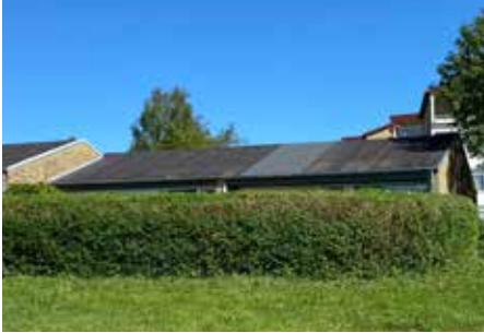
Taget udskiftes, og tagrummet isoleres.
