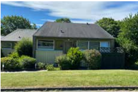
Udskiftning til vinduer med energiruder.
