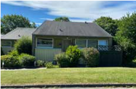
Udskiftning til vinduer med energiruder.
