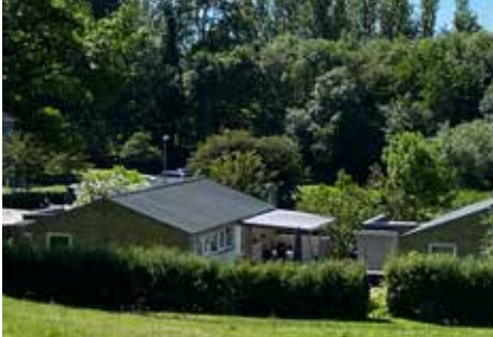
Taget udskiftes, og tagrummet isoleres.
