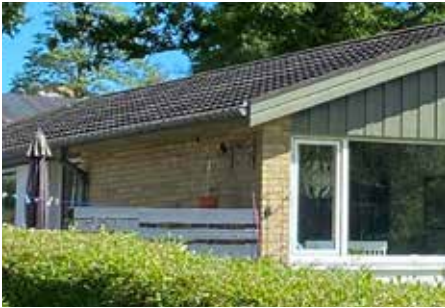
Ny efterisoleret skalmur af tegl.
