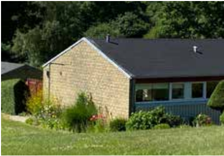
Ny efterisoleret skalmur af tegl.
