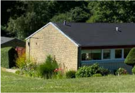
Ny efterisoleret skalmur af tegl.
