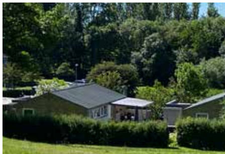
Taget udskiftes, og tagrummet isoleres.
