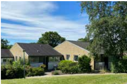
Nye hække og fliseterrasse.
