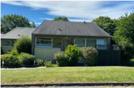
Udskiftning til vinduer med energiruder.
